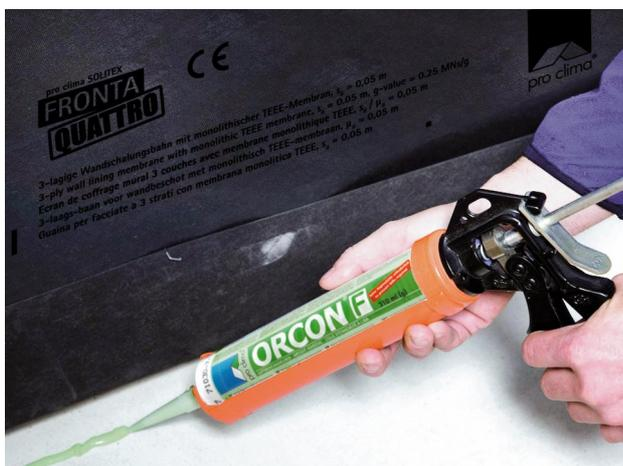
**6a. Raccord à des supports rugueux ou minéraux (par exemple à la plaque de plancher)**
