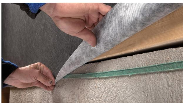
**7. Alternative : Raccord à des supports rugueux ou minéraux exemple : dalle béton) avec ORCON MULTIBOND**
