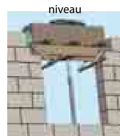
Etayage et mise à niveau
