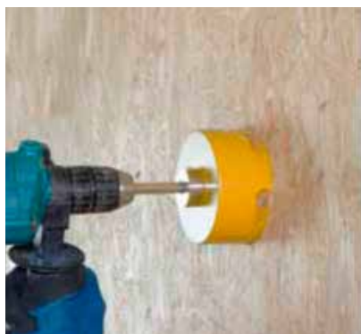
Perçage d'une ouverture circulaire
