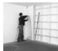
Fixez dans le coin, à travers le panneau (à 10 mm du bord du panneau).
